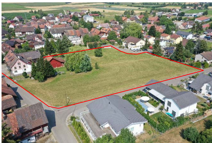
Aufnahme mit Drohne: Pfeiffer Bauingenieure AG; Im Halbiacker 5a; 8352 Elsau
